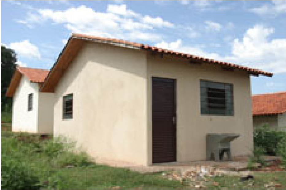
Foto 1 - Conjunto Habitacional Jamile Dequech II, Zona Sul, Londrina/PR
