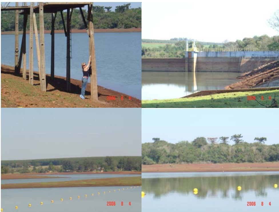
Figura 03: Mosaico da Paisagem da Barragem da Usina Hidrelétrica Mourão (Massoquim&Andrade, 2006)
