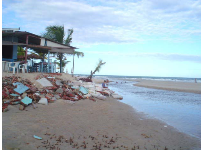
Figura 2 – Erosão atingindo barracas de praia próximo à desembocadura rio Guaibinzinho, município de Valença.
