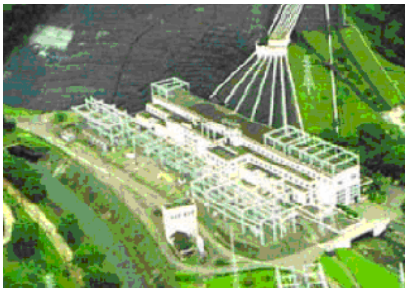
FIGURA 02 – Usina Hidrelétrica Henry Borden localizada no município de Cubatão, na sub bacia do rio Tietê. Fonte: EMAE, 2006. Org: SIILVA, F. B, 2006
