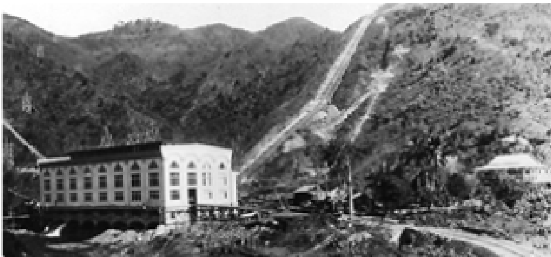
FIGURA 04 – Fachada da Usina Hidrelétrica de Fonte Velha localizada no município de Pirai (RJ), no ribeirão das Lajes.
