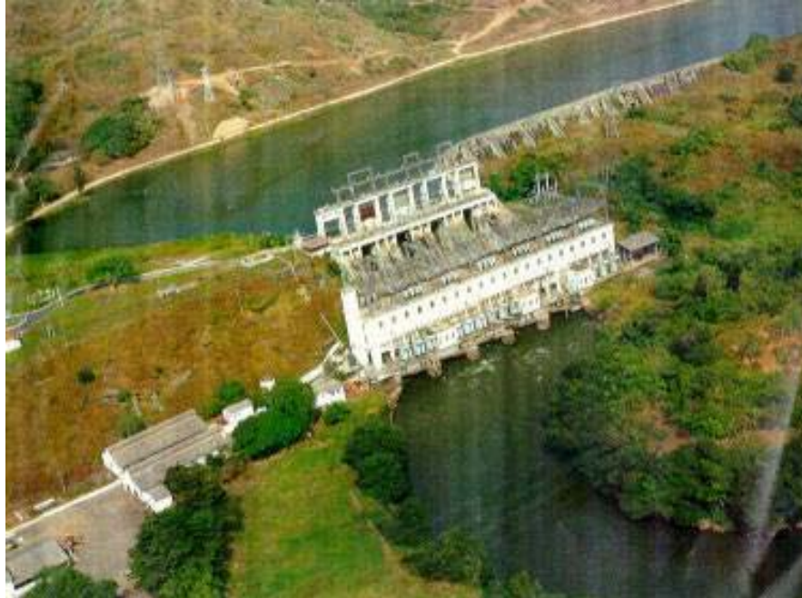
FIGURA 03 – Usina Hidrelétrica Ilha dos Pombos localizada no município de Carmo (RJ), no rio Paraíba do Sul.
