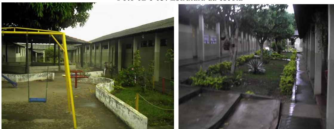
Foto 02 e 03: Estrutura da escola
