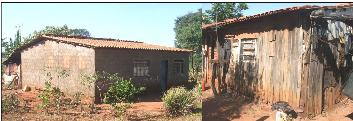
Figura 3 – Uberlândia (MG): à esquerda, casa de alvenaria sem reboco (Lote 13); à direita, casa feita de madeira (Lote8)
