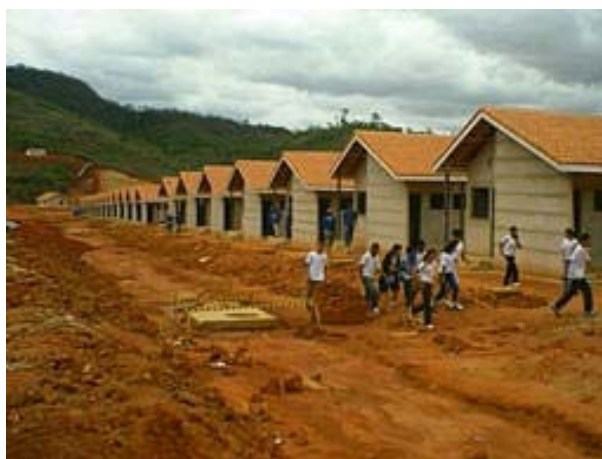
Fig. 5 – Cidade em construção Fonte: www.itueta.com.br
