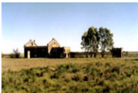
Figura 2 Estación abandonada de Bajo Hondo
