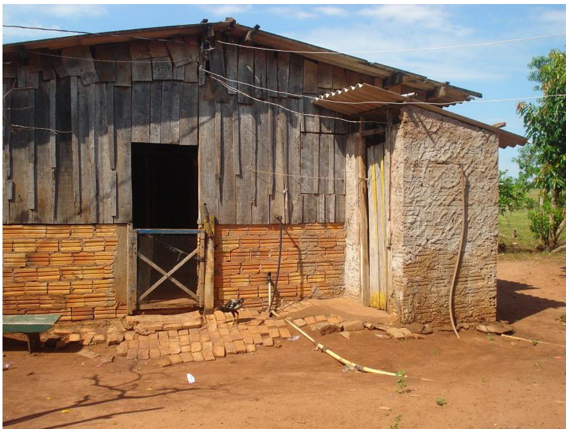
FIGURA 04 – habitação de madeira com base de alvenaria. Lote 17, do assentamento Haidéia. FONTE: Guttierre Paschoa (08/11/2008)
