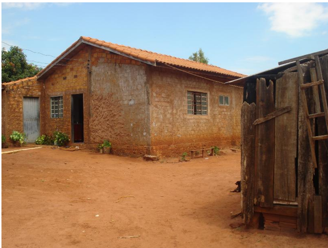
FIGURA 03 – habitação de alvenaria próxima a paiol de material precário. Lote 10, do assentamento Haidéia. FONTE: Gutierrez Paschoa (08/11/2008)
