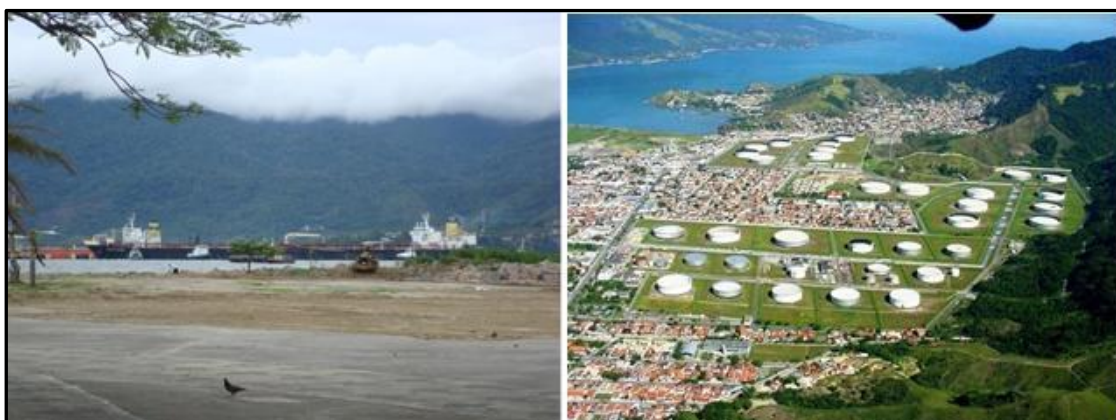
Figura 3 e 4: À esquerda, temos um petroleiro atracado no píer sul do Tebar em São Sebastião (autor: Heloisa dos S. Reis, 2007). À direita: aspectos do sítio urbano de São Sebastião, com destaque para a infra-estrutura de apoio ao funcionamento do Tebar (tanques de armazenamento). Fonte: http://www.transportes.gov.br (consultado em Nov. 2007).
