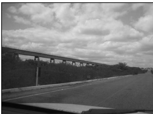
Fig. 4 - Ponte canal e estrada asfaltada Fonte: Ibimirim, 2007. Créditos: Priscila Batista
