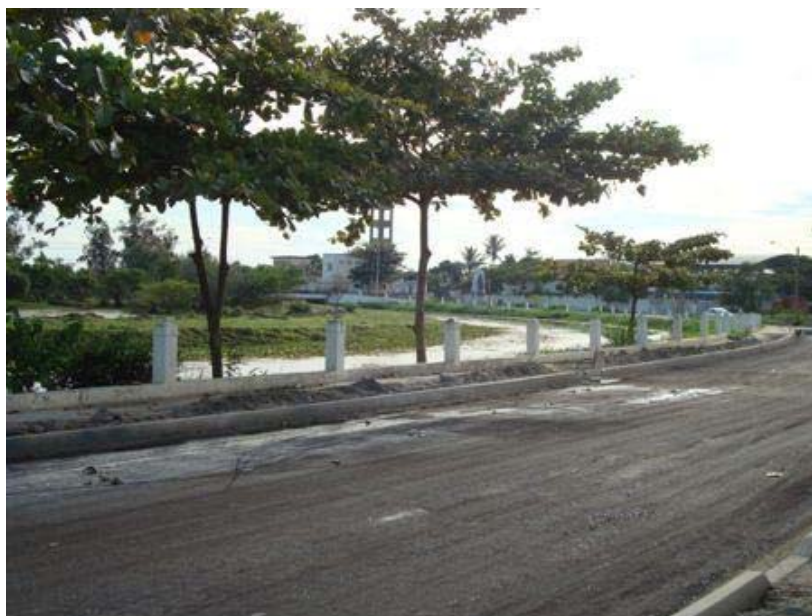
Figura 3 - Melhorias na infra-estrutura da malha urbana municipal de Quissamã
