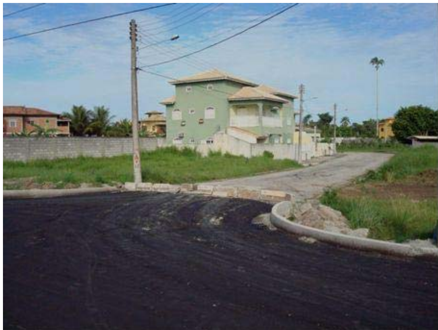
Figura 2 - Pavimentação e urbanização de ruas próximas ao Centro.
