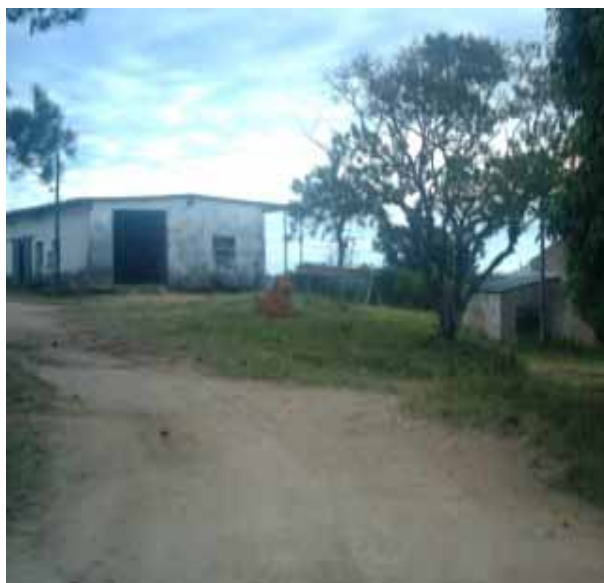
Figura 3: Parte da infra-estrutura do assentamento
