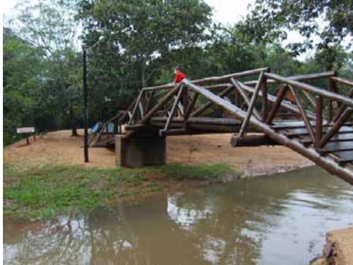
Figura 2. Ponte sobre o Córrego salvadora, Praia da Amizade. Autoria: M.M.S., 2006.
