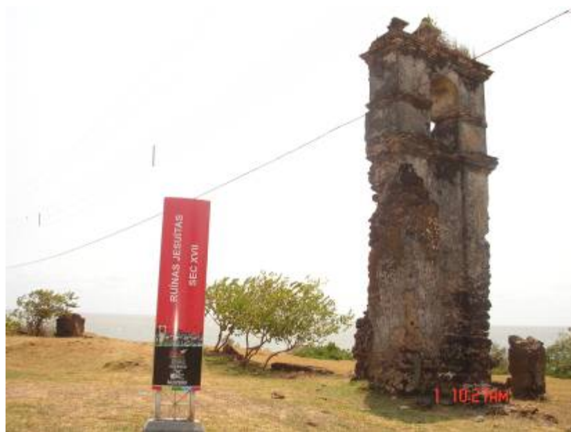
Figura n. 4. Ruínas Jesuíticas do século XVII, localizadas na localidade de Joanes, município de Salvaterra
