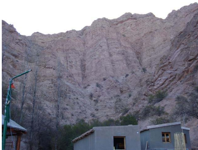
Foto N° 2. Terna la Quebrada
