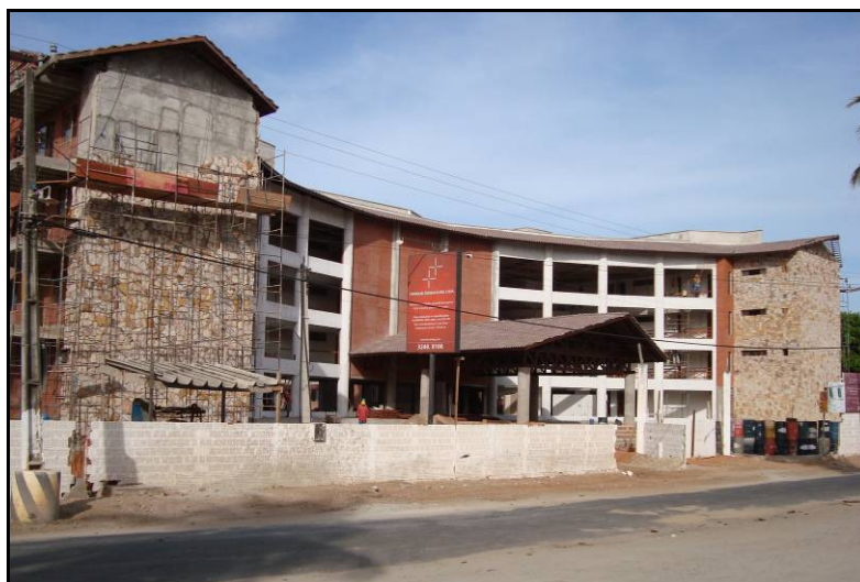
Figura 6: Prédio com quatro pavimentos – em construção. Fonte: Lúcia Sabóia, Nov./ 2008
