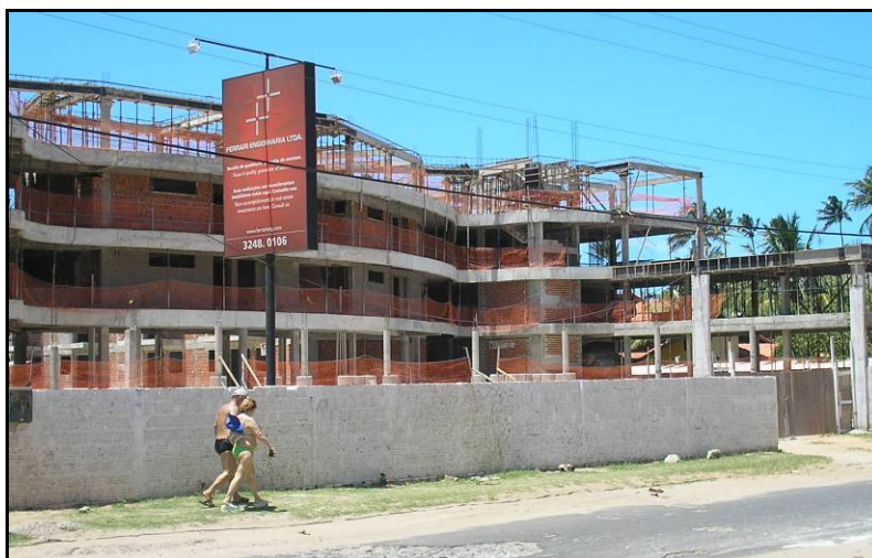
Figura 5: Prédio com três pavimentos – em construção. Fonte: Lúcia Sabóia, Set./ 2007
