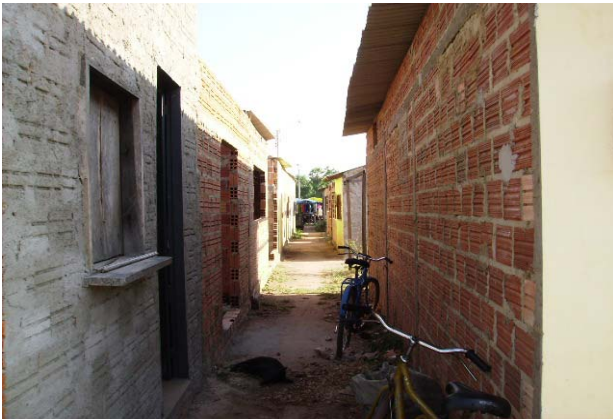
Figura 05: Via de circulação entre os pontos de comércio no entorno do Mercado Público Municipal de Alto-PI – Outubro/2008.
