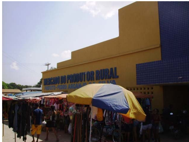
Figura 04: Frente da atual estrutura física do Mercado Público Municipal de Alto-PI - Outubro/2008. Fonte: Vieira (2008)
