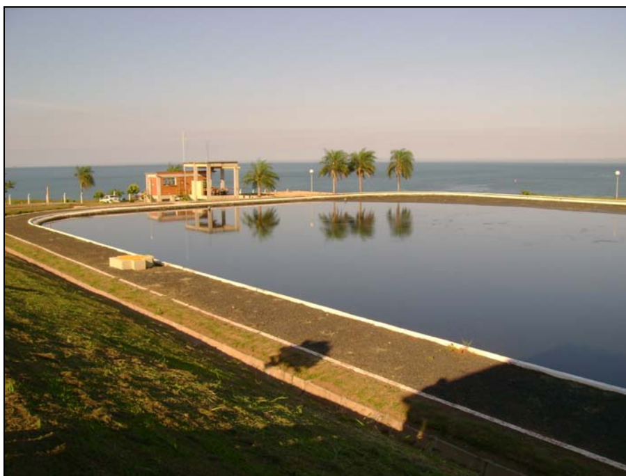
Foto 5: Lagoa de estabilização – Estação de Tratamento de Esgotos – Presidente Epitácio - SP
