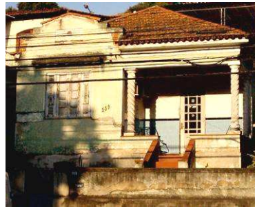
Foto 5: Situação do imóvel em 2006.
