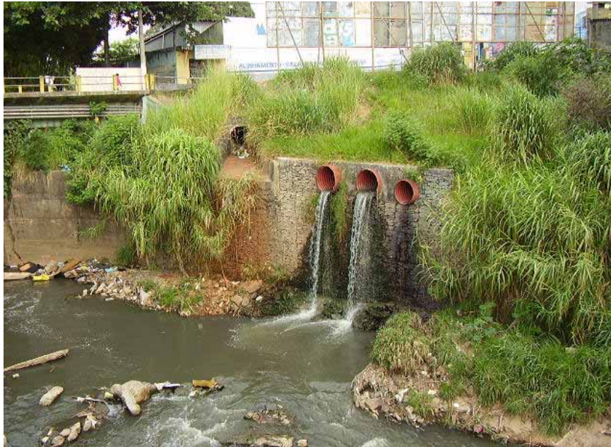
Figura 7 – Lançamento de esgoto do Rio
