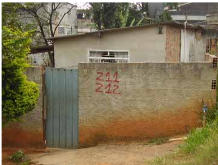
Figura 3 – Selagem das moradias.
