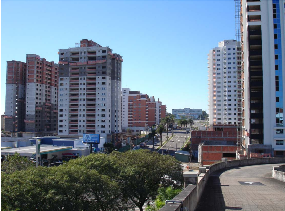
Imagem 1 – Vista parcial dos edifícios do Jardim Europa a partir do estacionamento do shopping Iguatemi, em etapa de conclusão (jul/2008). À direita, parte do edifício de escritórios construído pela Goldzstein.
