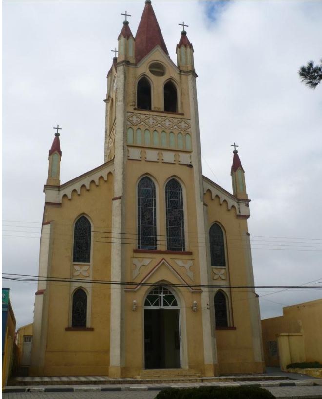
(Fig. 1.1). Igreja Matriz Nossa Senhora da Luz edificada em 1935, no mesmo local da Capela que havia sido construída em 1852.
