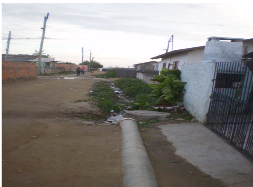
Figura 05: Vila Vitória. Esgoto a céu aberto
