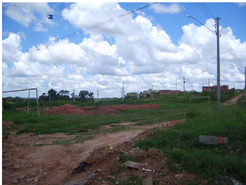
Foto 7: área de lazer em construção
