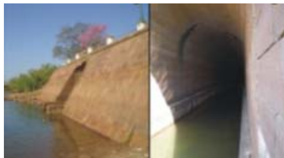
Fotografía de conductos abovedados de canalización. 2006
