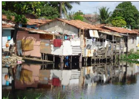
Foto 2: Habitação sob palafita de tipologia mista alvenaria/sucata dentro do rio
