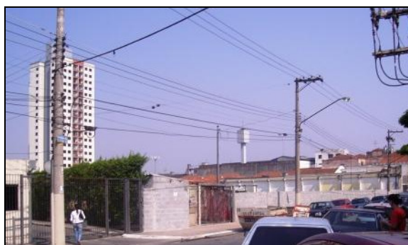
Demolição no local onde funcionava a indústria Spina (Foto: Vasques 2007)
