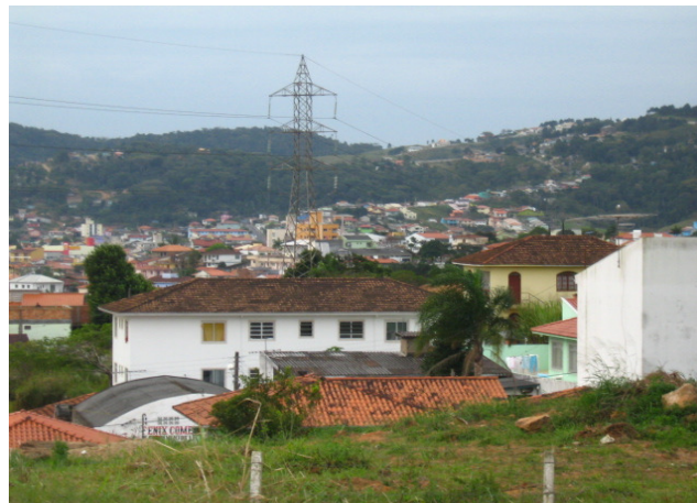
Figura 3: Torre, LT e área edificada na faixa de servidão em Palhoça - SC.
