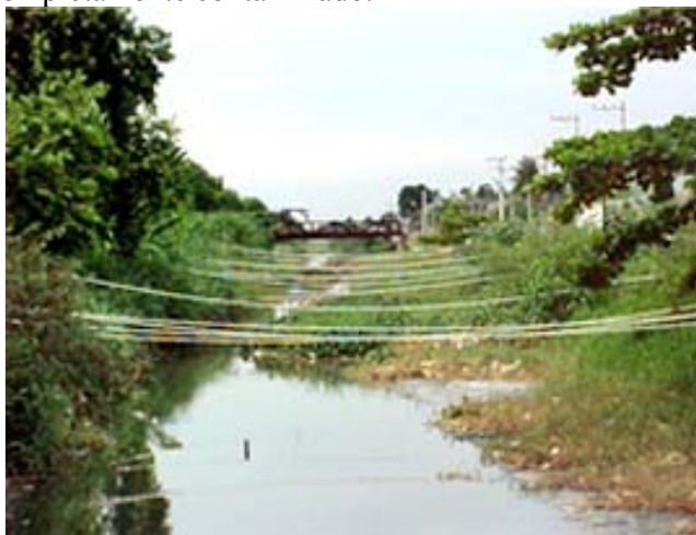
Figura 7 Instalações clandestinas de água (Linhas brancas) no Bairro Jardim Metrôpole- São João de Meriti Fonte boletim FAPERJ
