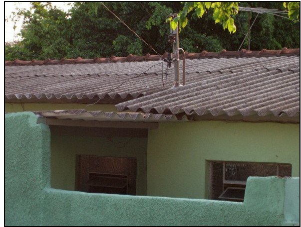
Figura 10. Casa popular com cobertura de fibrocimento, janelas pequenas e muros altos.
