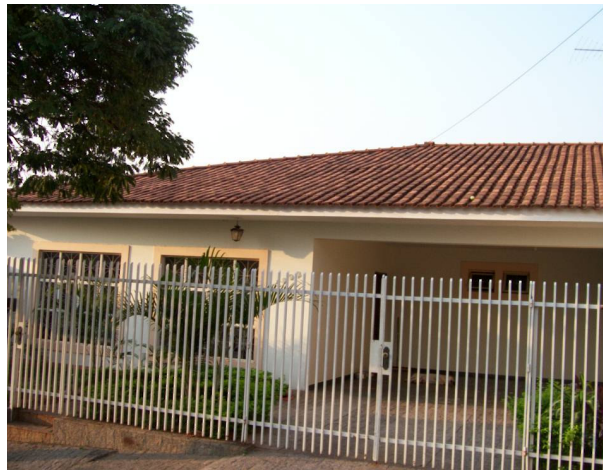
Figura 12. Casa de classe média com telha cerâmica, grades vazadas e janelas amplas.
