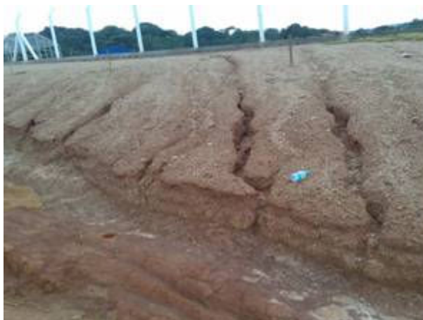
Figura 6 – Erosão em sulcos durante a fase de redesenho de uma nova morfologia superficial na bacia do córrego Granada, onde são feitos grandes cortes e/ou aterros no terreno.
