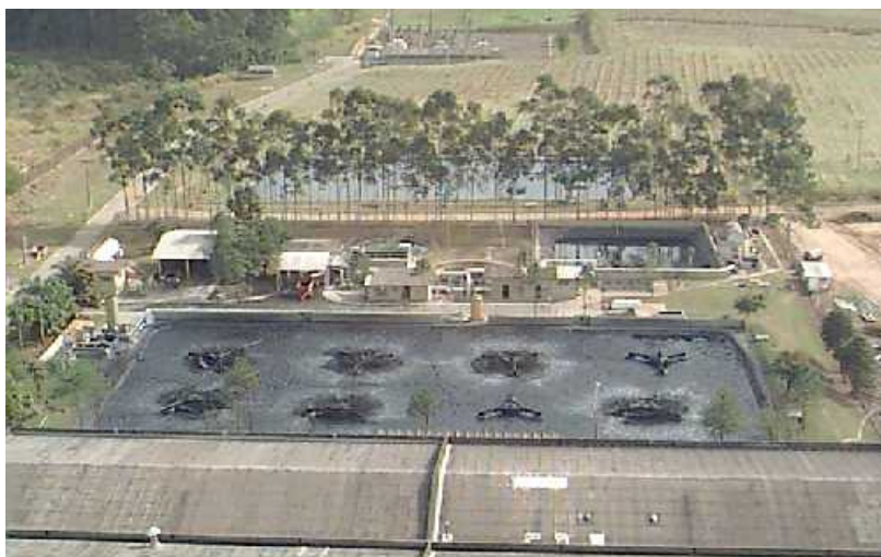
Foto 5: Estação de Tratamento de Efluentes da Empresa Santista Têxtil S.A. Fonte: Empresa Santista Têxtil S. A. 19
