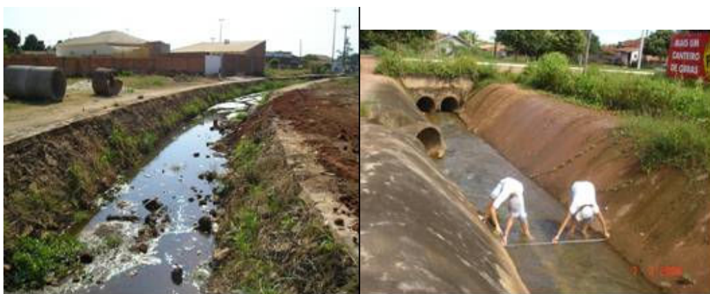
Figura 3 - Córrego da Garrucha em Araputanga, área canalizada
