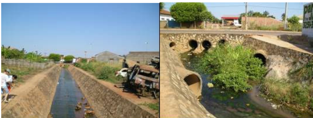
Figura 04 - Córrego São José, na cidade de São Jose dos Quatro Marcos. Observa a presença de lixo e coloração da água é escura, devido o lançamento direto de esgoto.
