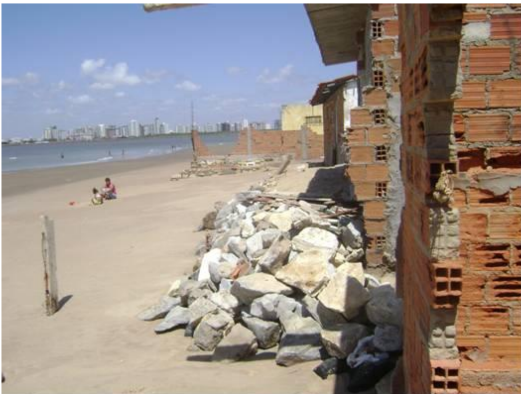
Figura 07: Ruínas na praia de Atalaia Nova – Município de Barra dos Coqueiros/Sergipe. Fonte: Trabalho de campo – 09/01/2008.
