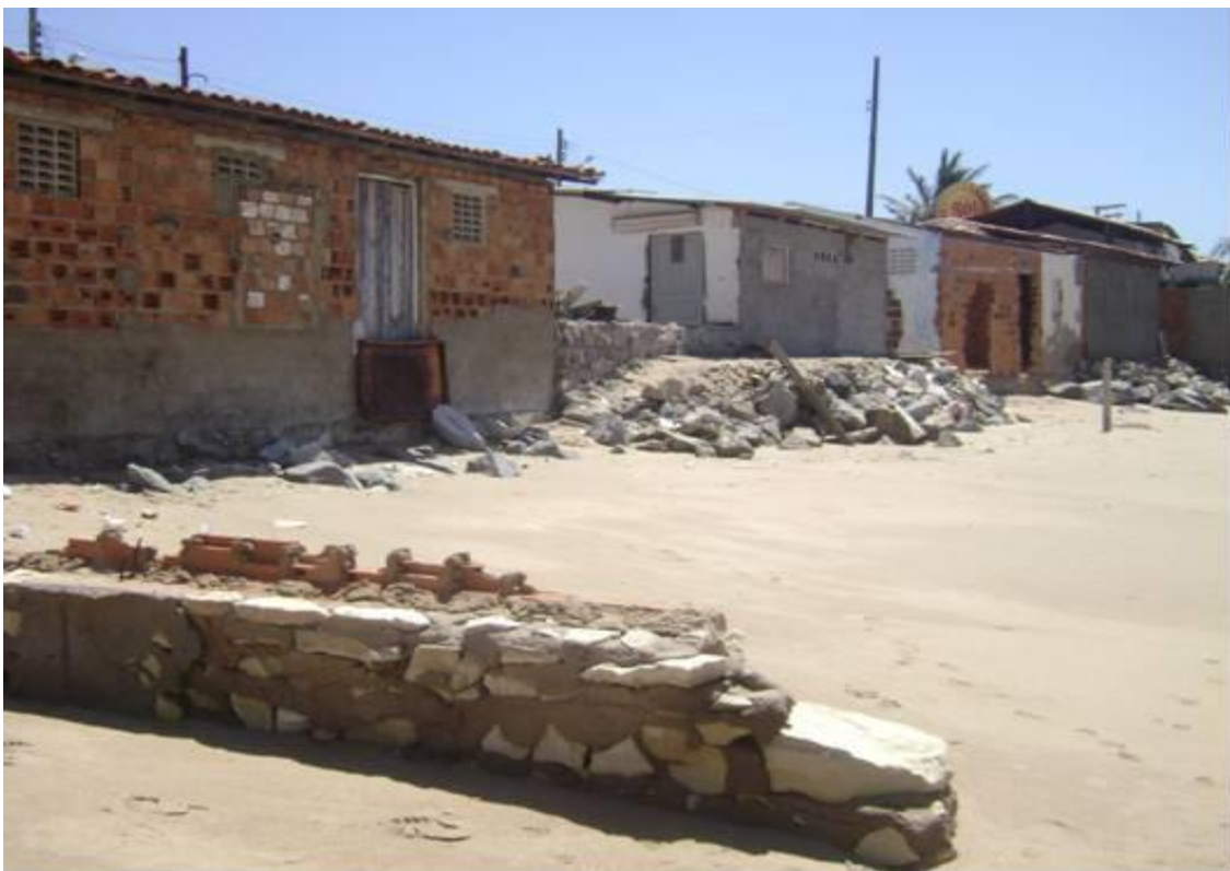
Figura 08: Ruínas na praia de Atalaia Nova – Município de Barra dos Coqueiros/Sergipe. Fonte: Trabalho de campo – 09/01/2008.
