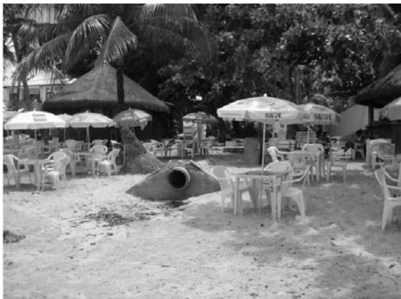
Foto 3: Canal para escoamento de água pluvial
