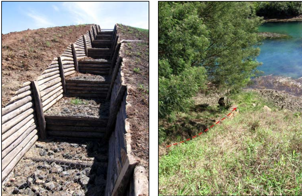
Figuras 1 e 2: Canal de drenagem recém-construído no Campo Morozini (data: 29 de agosto de 2008), e canal já escondido pela vegetação e incorporado à paisagem, indicado pela seta vermelha, no Campo Malha II Leste, construído em 2004 (data: 29 de agosto de 2008). Fotos: Ana Carolina Vicenzi Franco.
