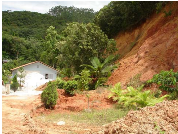
Figura 05 – Deslizamento próximo a uma residência, que além do deslizamento de terra, ocasionou a queda de uma árvore a menos de 2 m. da residência (Foto: Roni Ramos, 31 de janeiro de 2008).
