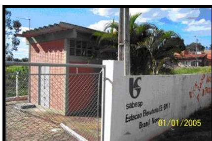
Fonte: Trabalho de campo 15/11/2006. Fotos 2: Estação Elevatória de Esgoto
