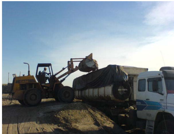
Figura 05 – Carregamento e transporte de areia.
