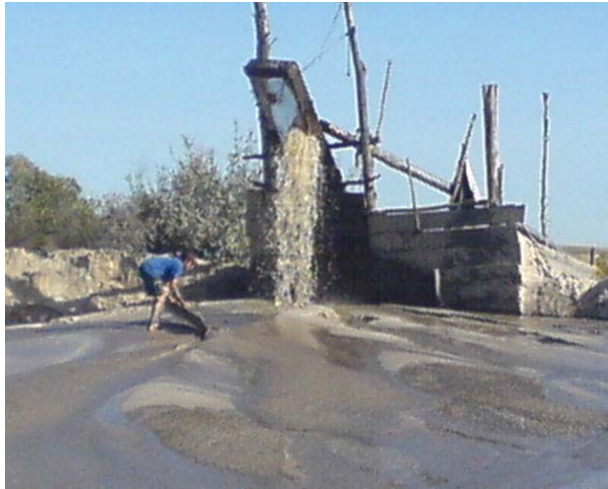
Figura 04 - Retirada de areia e peneiramento para filtragem de impurezas
