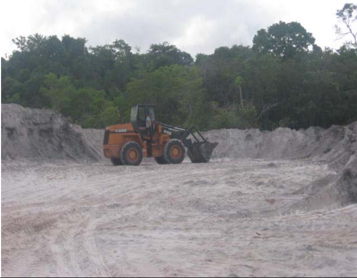
Retirada de material arenoso do subsolo da propriedade. FOTOS: Viviane Santos, setembro, 2007.
