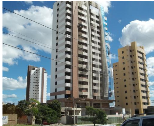
Foto 4 Edifício em construção
