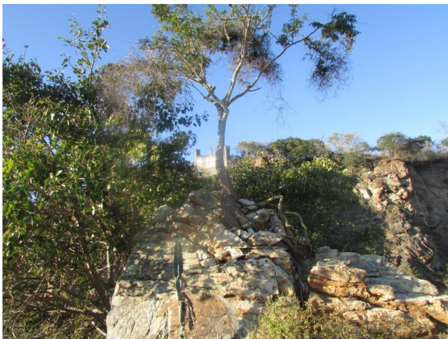
Figura 05: Construção e vegetação na Mina São Felix do Amianto, no município de Bom Jesus da Serra – BA, Fonte: Kátia R. Almeida, em Trabalho de campo, em 15 ago. 2013.
