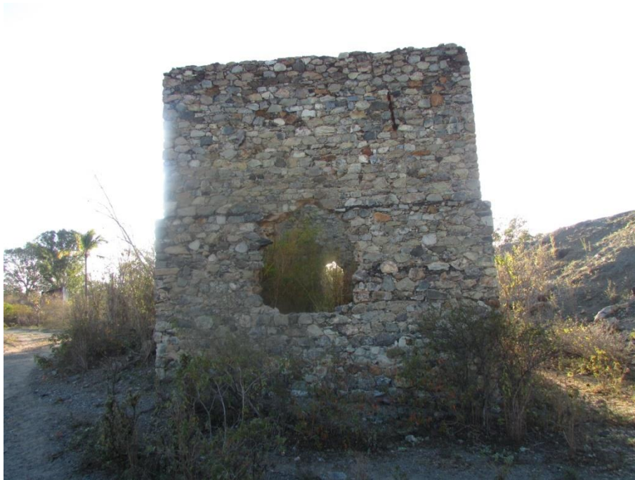
Figura 03 - Construção na antiga Mina São Felix do Amianto Fonte: Kátia R. Almeida, em Trabalho de campo, em 15 ago. 2013.
