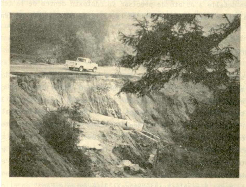
FIG. 2 En las ultimas décadas, los arroyos perennes se van transformando en tormentas destructivas, de puentes y vías de comunicación, lo que demuestra un nuevo equilibrio geosistémico.
