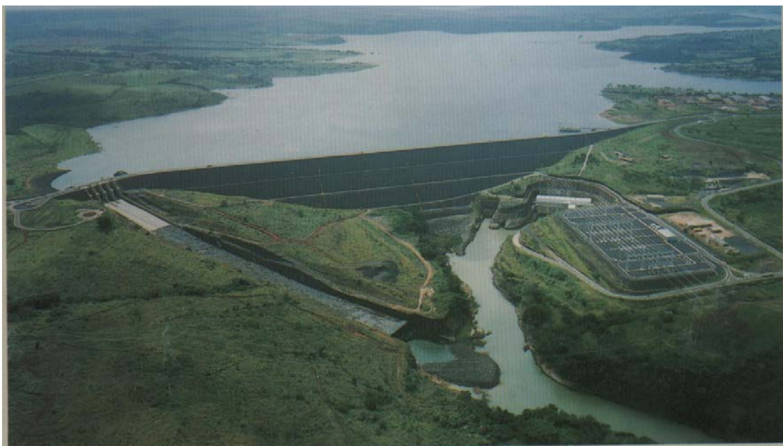
Foto 1 – Usina Hidrelétrica de Nova Ponte – Foto: Cemig - 1997
